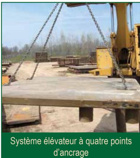
Système élévateur à quatre points d'ancrage
